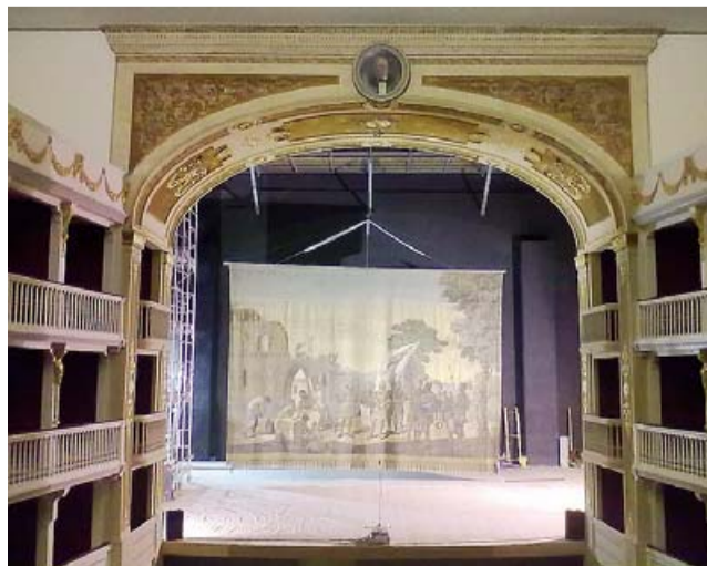
IL CANTIERE Il teatro Mercadante di Altamura
