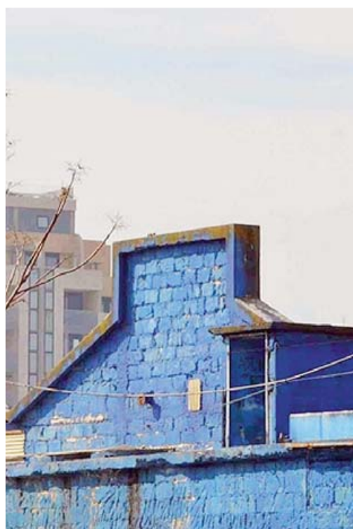
FIBRONIT La fabbrica dopo la messa in sicurezza
